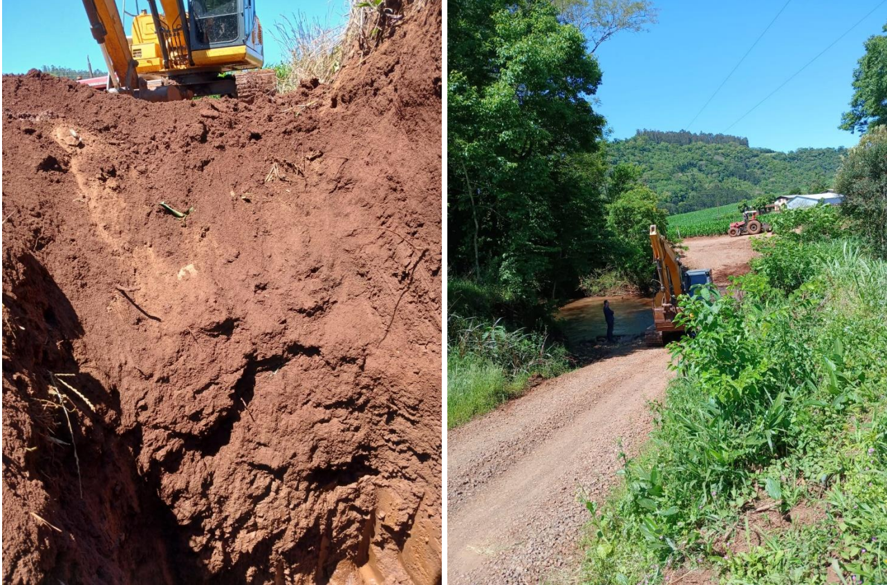
Imagens 05 e 06. Início das sondagens. Fonte: O autor, 2025.
