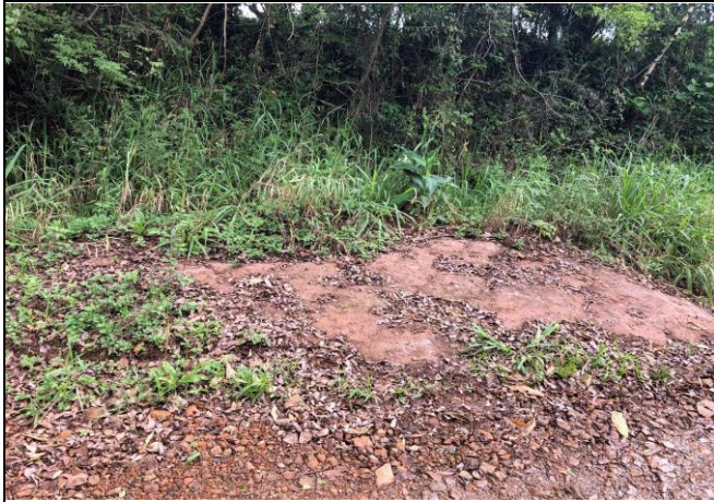
Foto Local 13 INCIDÊNCIA DE ROCHA NA VALETA (094)
