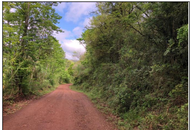
Foto Local 12 ESTREITAMENTO DA ESTRADA (093)
