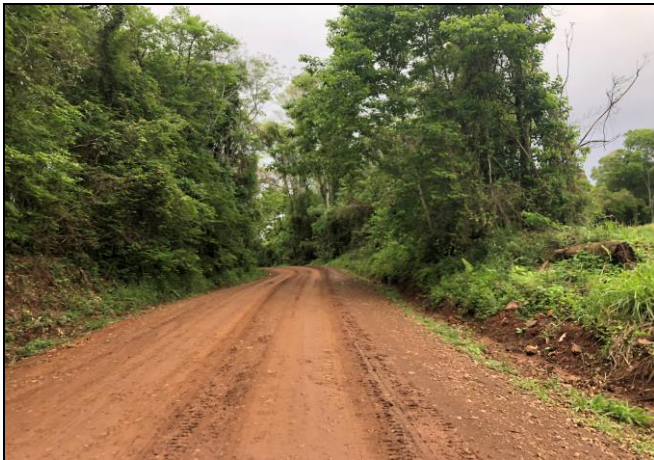
Foto Local 01 CONDIÇÃO ATUAL DA ESTRADA (065)
