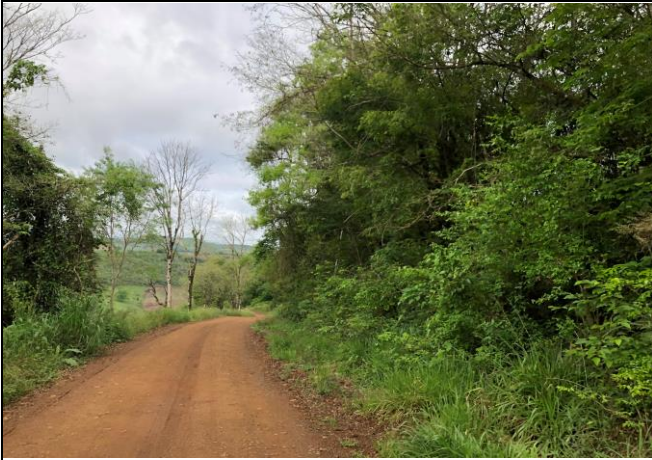
Foto Local 07 ESTREITAMENTO DA ESTRADA (087)
