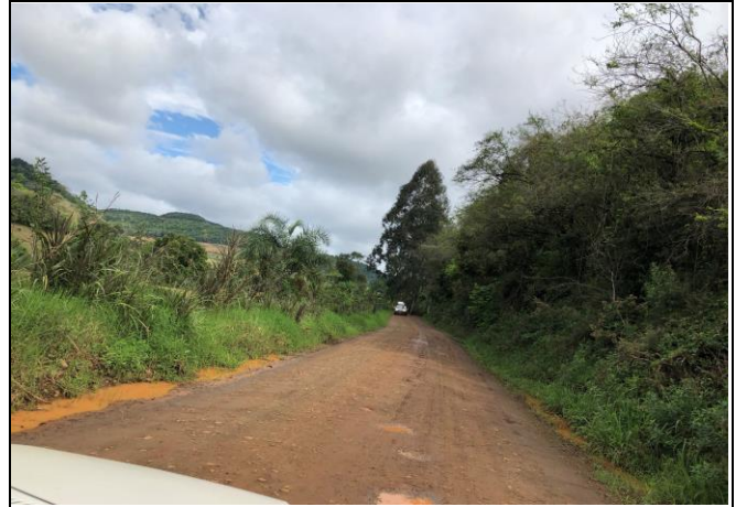
Foto Local 14 CONDIÇÃO ATUAL DA ESTRADA (102)
