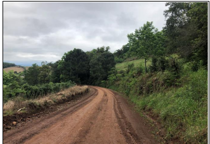
Foto Local 02 CONDIÇÃO ATUAL DA ESTRADA (072)
