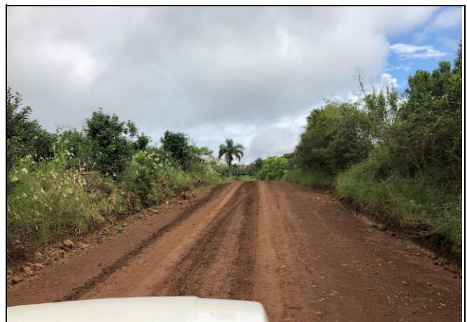
Foto Local 06 CONDIÇÃO ATUAL DA ESTRADA (081)
