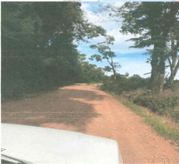
Local proposto para o início da obra
