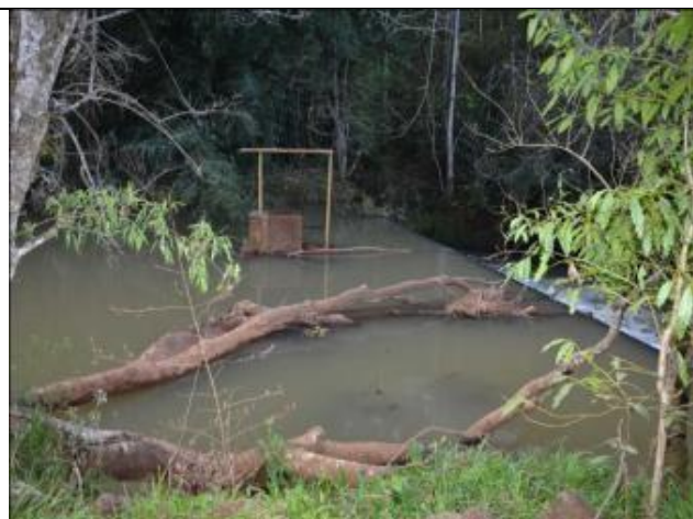
Figura 11 - Barragem de nível do Rio Suzana. Fonte: Plano Municipal de Saneamento Básico de Viadutos (2011).
