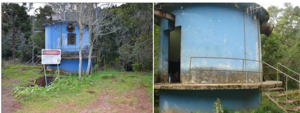
Figura 12 - Estação elevatória da barragem do Rio Suzana. Fonte: Plano Municipal de Saneamento Básico de Viadutos (2011).
