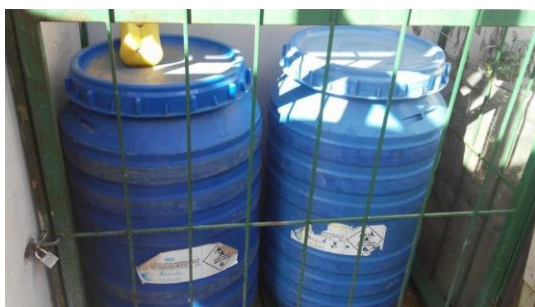
Figura 29 - Armazenamento temporário de resíduos infectantes gerados na UBS
